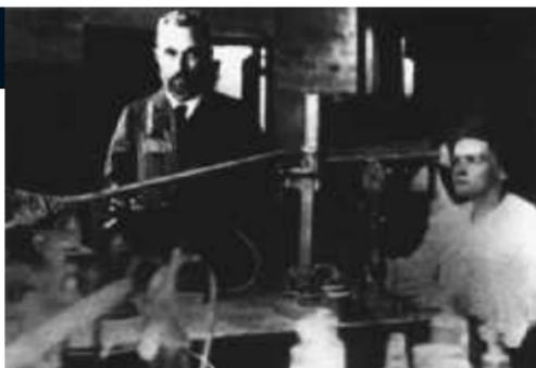
Arbeit am „Quarz-Piezo-Elektrometer“ 1906. Dieses von Pierre Curie entwickelte Gerät kann sehr schwachen elektrischen Strom messen, welcher entsteht, wenn radioaktive Strahlen von Atomkernen in die Luft ausgesendet werden – es spielte bei der Entdeckung der Radioaktivität und der Elemente Radium und Polonium eine zentrale Rolle.
