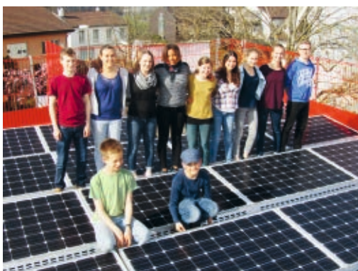
Jugendsolarprojekt | Zusammensetzen und Verkabeln von Solar- modulen auf dem Flachdach des Kinderheims Titlisblick
