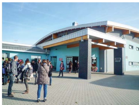
Gymnasium in Spalona (Kunice)
